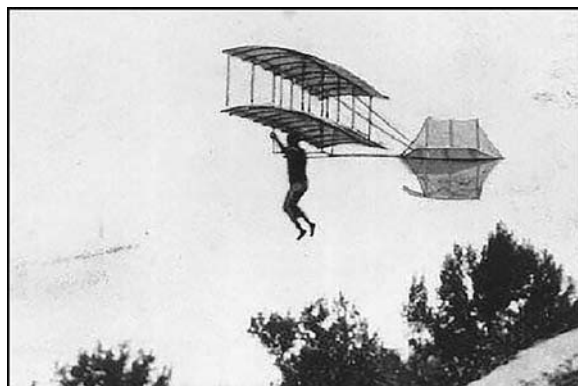
Fig. 44 - L' aliante biplano di Chanute provvisto di timoni di direzione e di stabilizzatore, che servì da modello a quello dei fratelli Wright.
